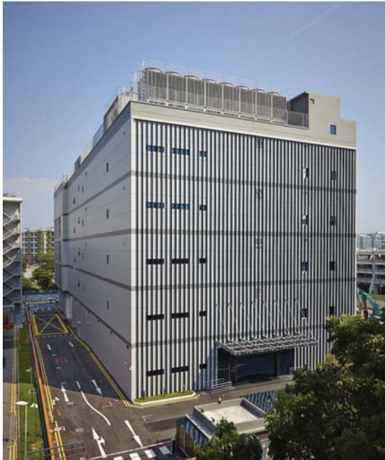
Keppel Datahub 2 in Tampines, Singapore
